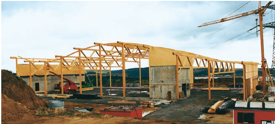
Bild 12: Die zwischen die unterschiedlich hohen Pendelstützen gehängten Fachwerk-Träger ergeben die geschwungene Form.
