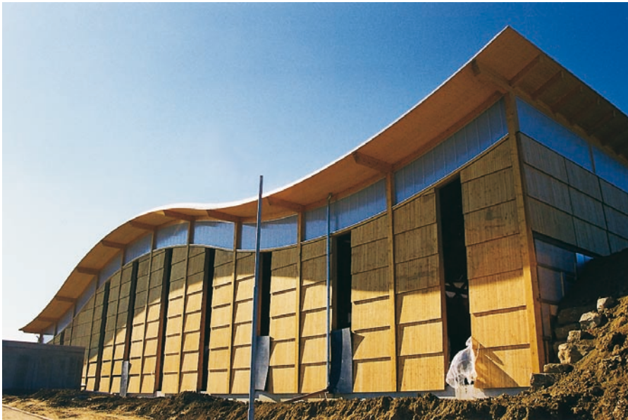
Bild 10: Lagerhalle Naturata: durch das geschwungene Dach harmonisch in die Landschaft eingebettet
